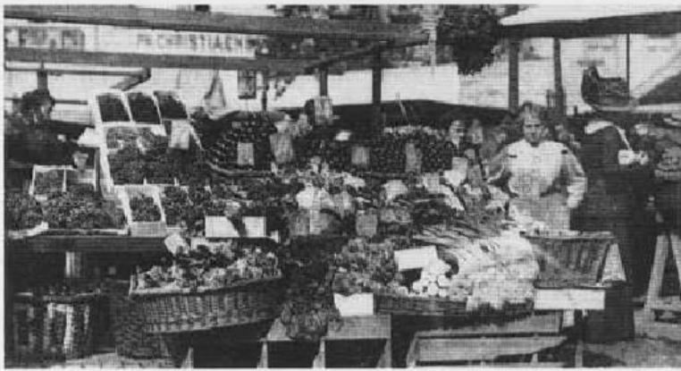
Groenten- en fruitverkoopsters op het Sint-Katelijneplein in het begin van deze eeuw.
